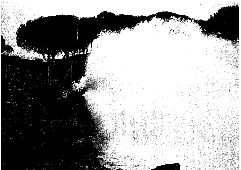
FIGURA 2. Descarga de caudales a través de válvula de chorro hueco en el embalse de El Pardo (río Manzanares) (Madrid).
