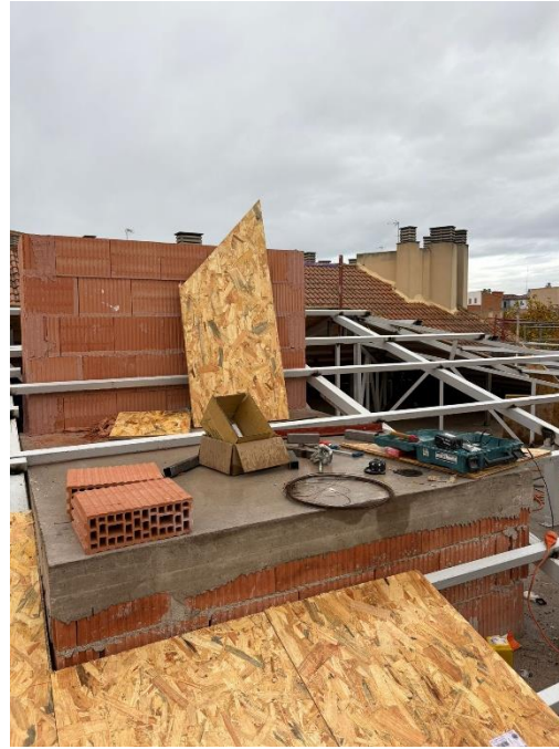
Interiores y trabajos de aislamiento en cubierta: tableros de viruta y estructuras metálicas.
