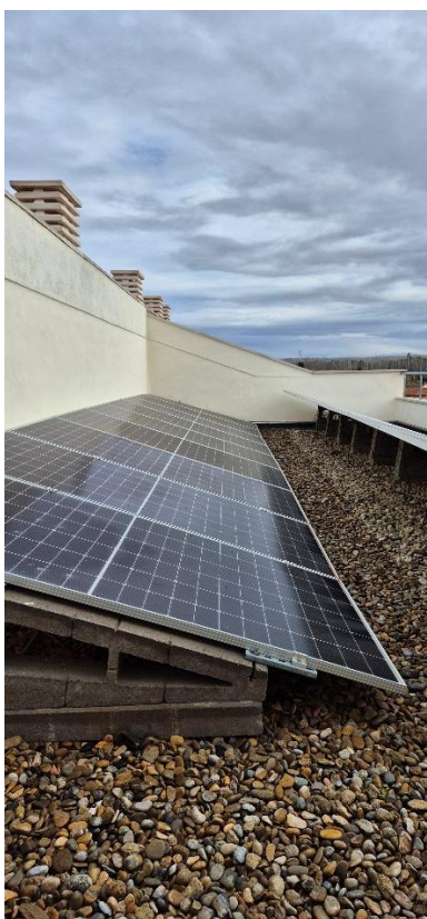
Instalación paneles solares
