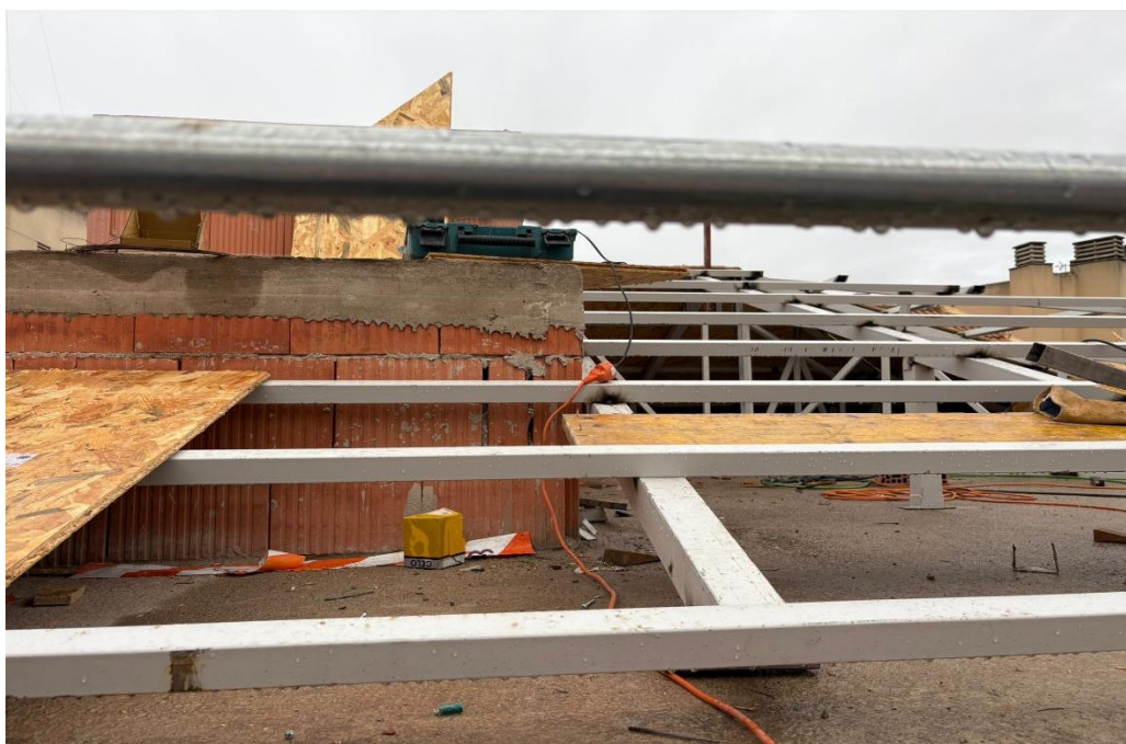
Trabajos de aislamiento en cubierta: tableros de viruta y estructuras metálicas.
